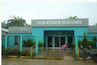
Construcción del Centro de Salud, Esparta
